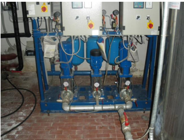
Figura 13 - Edificio principale (pompe Lowara)
