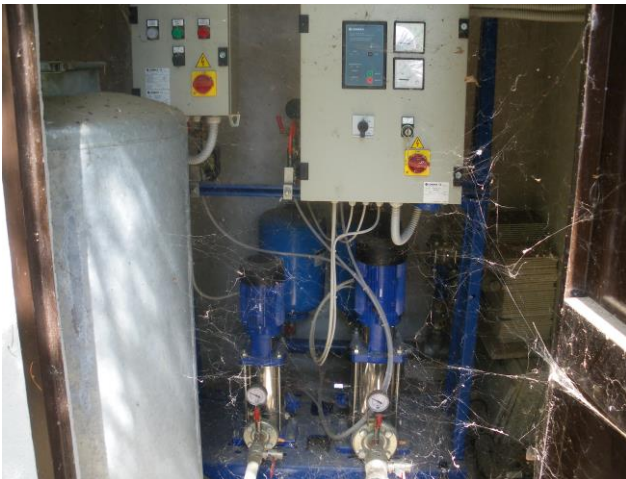
Figura 11 – Cupola Scozzesi (Pompa Lowara)
