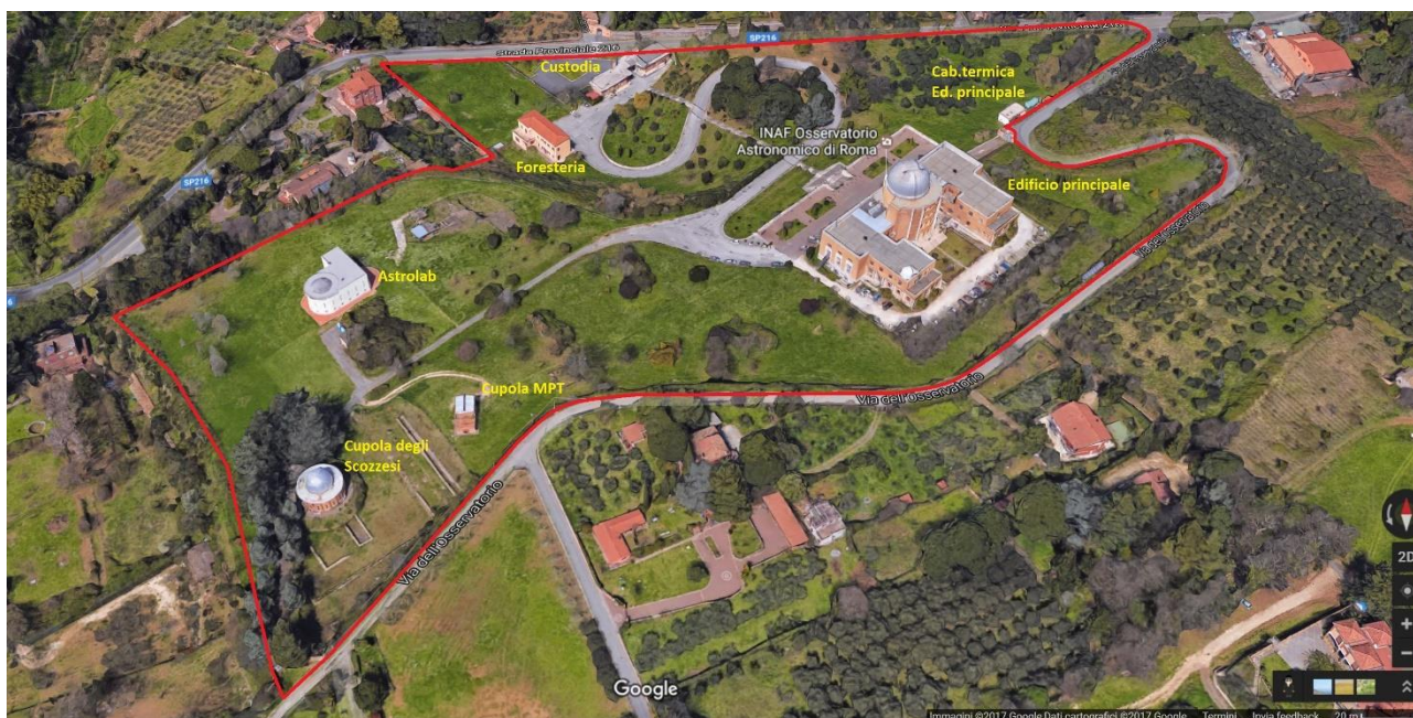
Figura 1 - Vista aerea dell' Osservatorio . In rosso è evidenziato il perimetro
