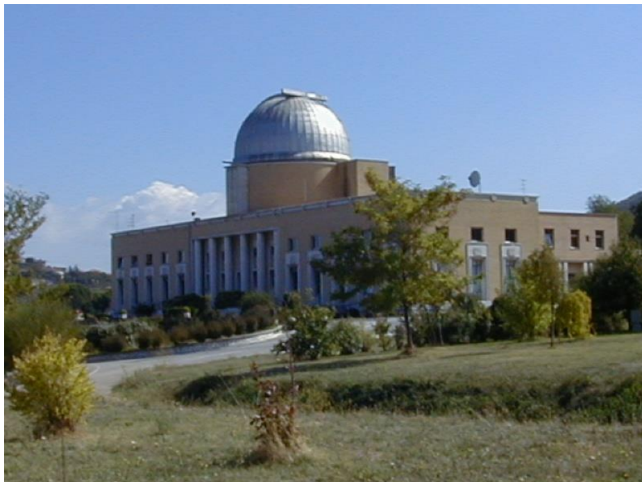
Figura 1 - edificio principale Osservatorio
