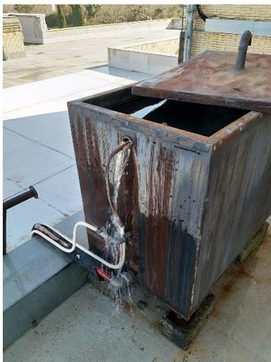
Figura 21 - attuale vaso di espansione dell'impianto a vaso aperto
