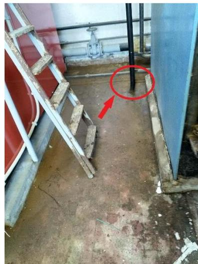
Figura 22 - tubo di scarico acqua; nel cerchio in rosso è evidenziato il punto ove si verifica la perdita d'acqua
