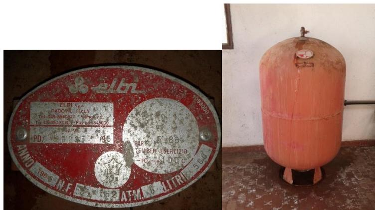
Figura 17 - vaso di espansione da 500 litri esistente
