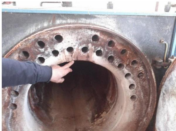
Figura 8 - Cabina termica: vista della caldaia n.2 da sostituire
