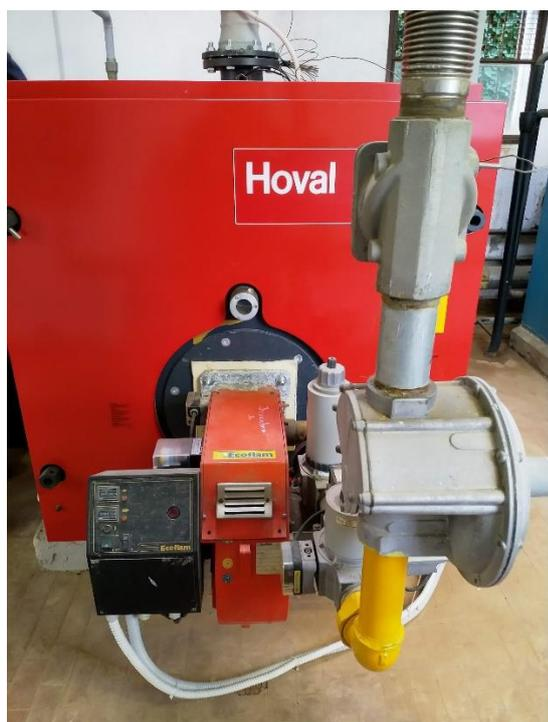
Figura 10 - bruciatore Ecoflam e valvola VIC
