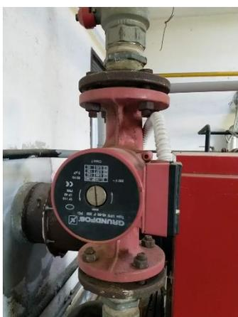
Figura 14 - elettropompa attualmente installata nella centrale termica
