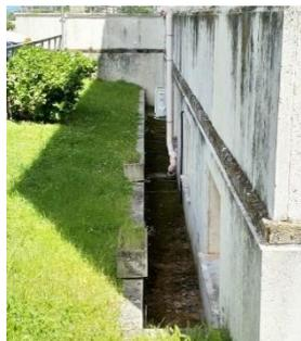
Figura 3 - scannafosso lato destro edificio principale
