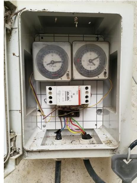
Figura 32 - Centralina dell'impianto di irrigazione aree B1 e B2
