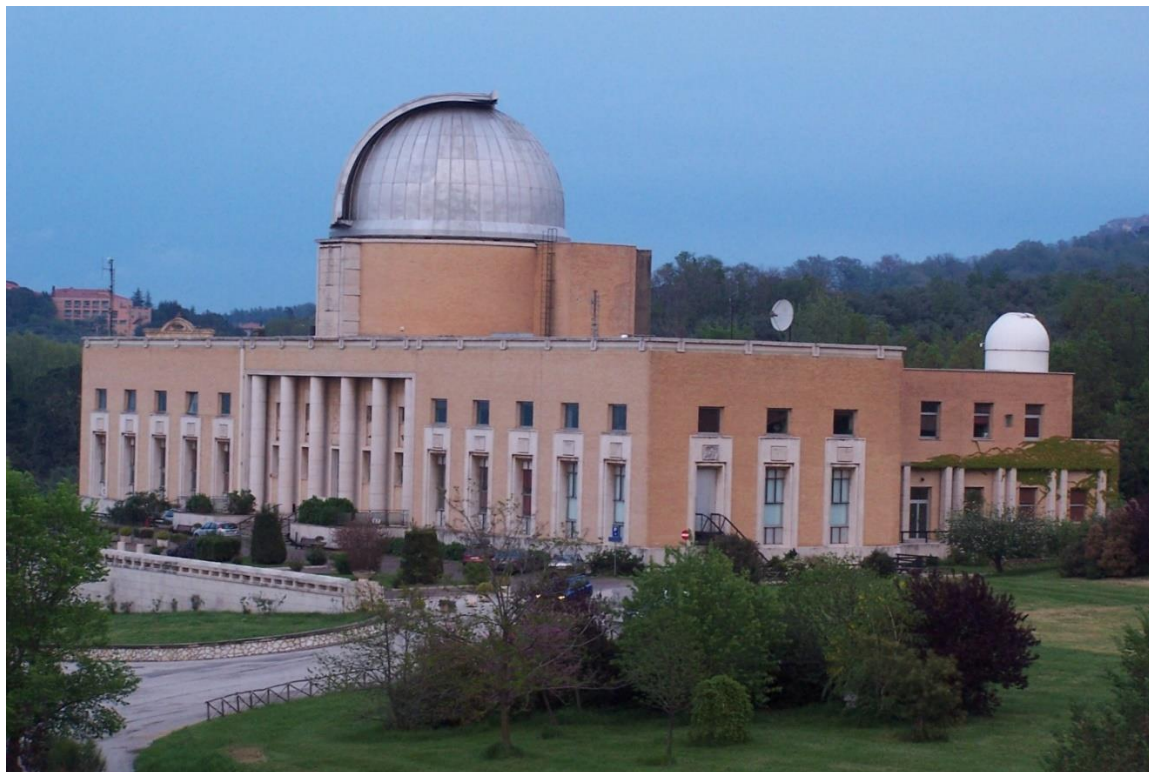
Figura 1 - Edificio principale dove si dovranno svolgere i lavori
