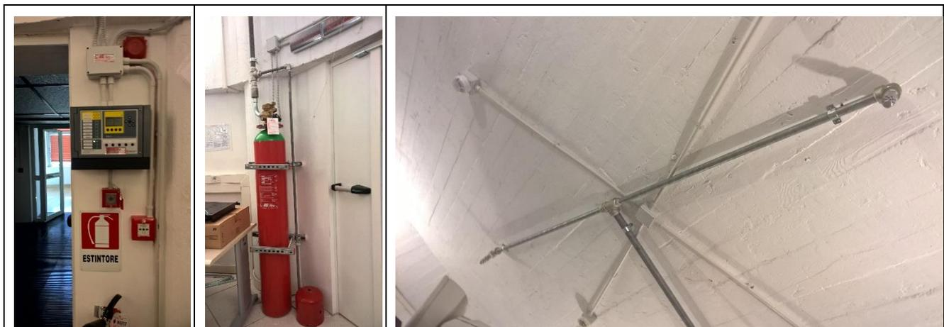
Figura 3 - sistema di spegnimento automatico del CED
