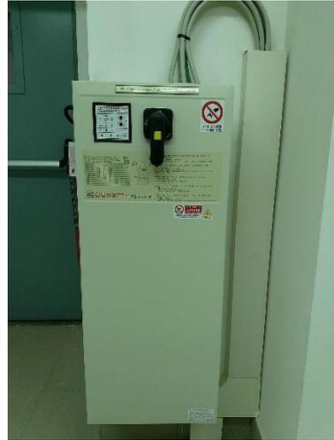
Figura 3 - rifasatore della cabina di trasformazione
