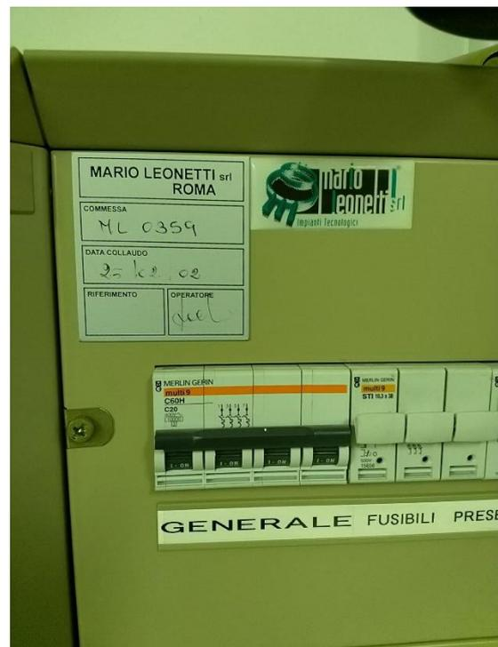
Figura 7 - quadro elettrico di servizio della cabina di trasformazione
