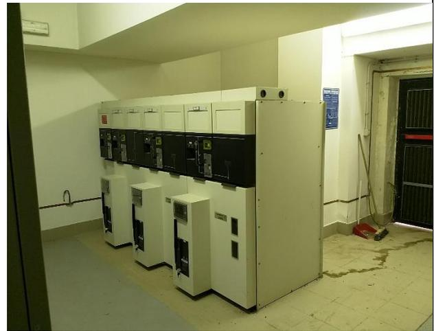
Figura 5 - Quadri controllo trasformatori
