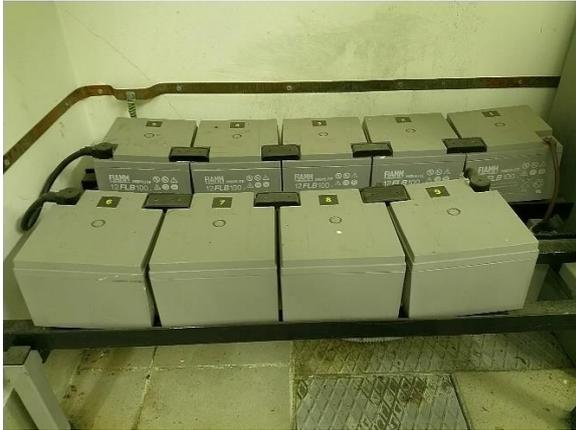
Figura 8 - pacco batterie tampone della cabina MT
