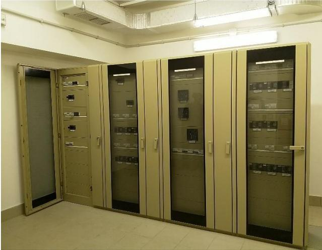
Figura 2 - sala BT della cabina di trasformazione
