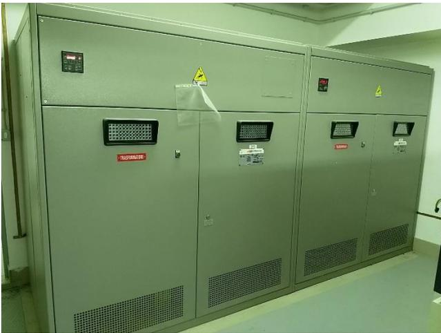
Figura 4 - Trasformatori 400kVA
