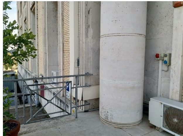
Figura 5 - vista dal ballatoio del luogo di installazione
