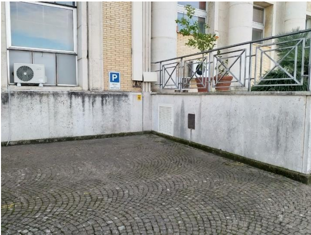
Figura 2 - luogo di installazione della piattaforma
