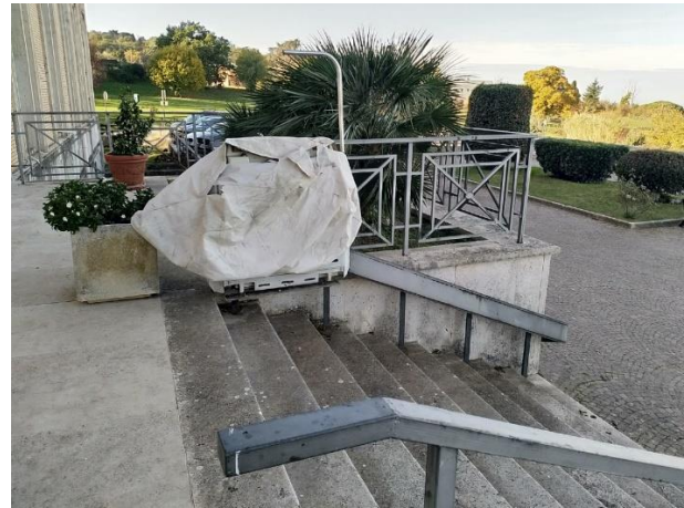
Figura 3 - vecchia piattaforma disabili
