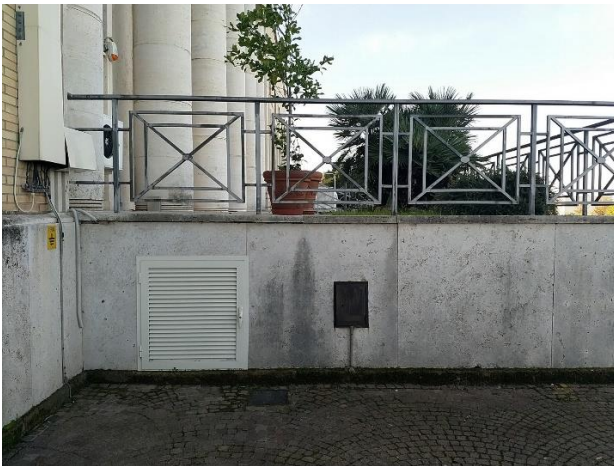
Figura 4 - vista del luogo di installazione della piattaforma
