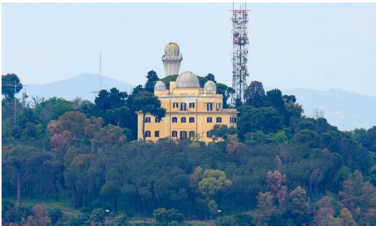
Figura 1 - Sede di Monte Porzio Catone
