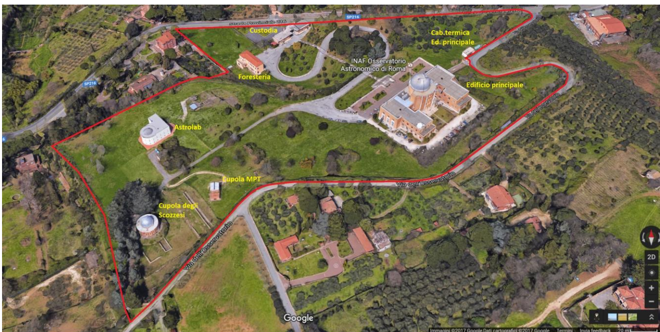
Figura 3 - Vista a volo d'uccello del comprensorio con l'indicazione dell'ubicazione dell'edificio principale e delle strutture periferiche
