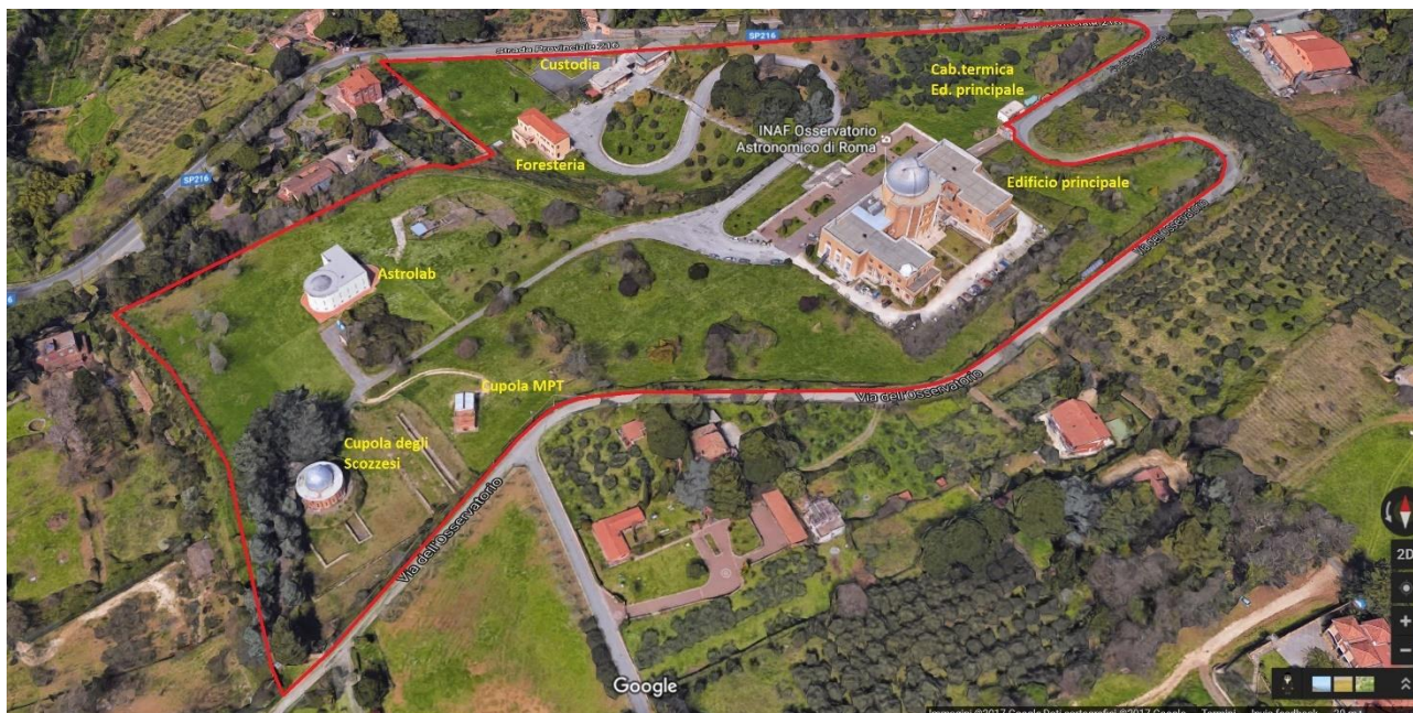
Figura 3 - Vista a volo d'uccello del comprensorio con l'indicazione dell'ubicazione dell'edificio principale.
