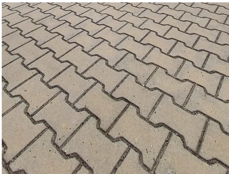
Figura 5 Tipologia del pavimento
