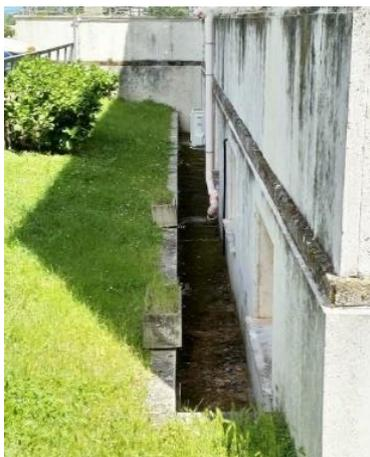
Figura 3 - Scannafosso lato destro edificio principale
