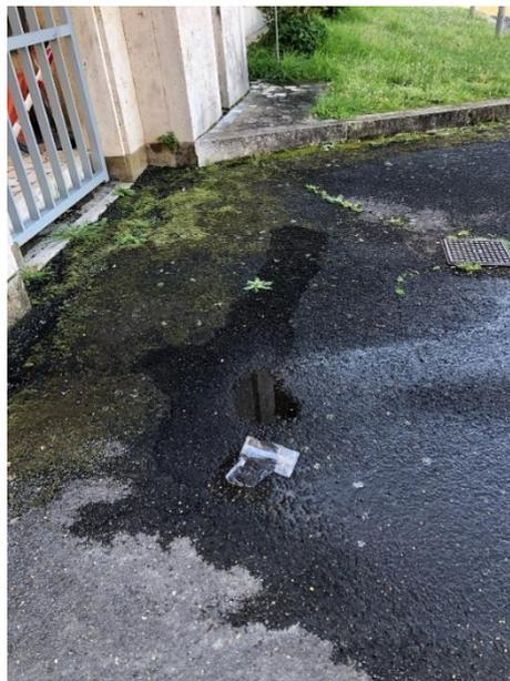
Figura 2 - Perdite d'acqua potabile presso l'ingresso di Via Frascati 33
