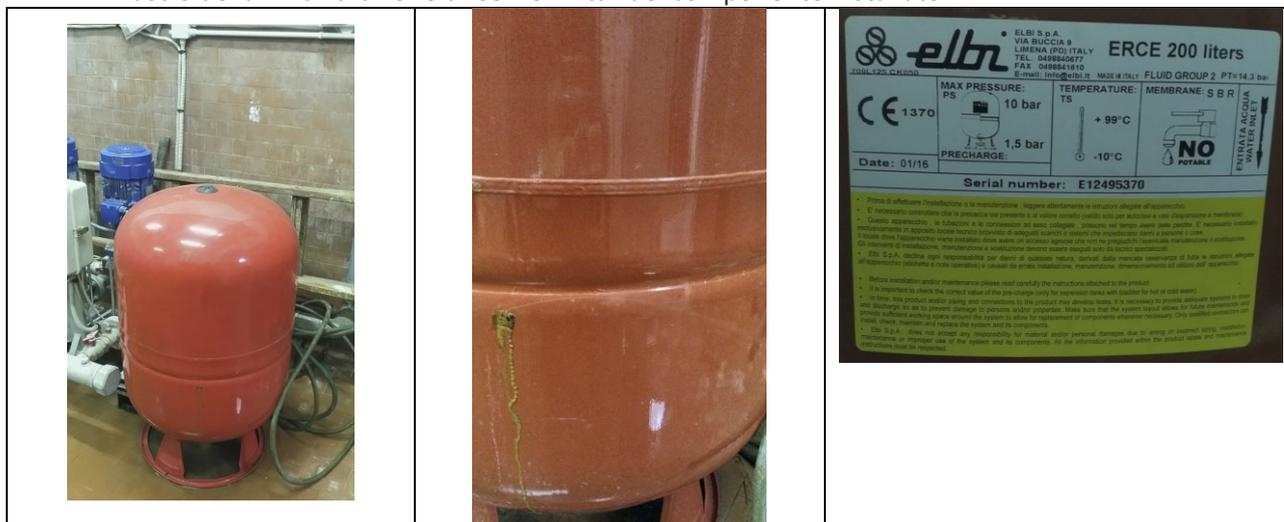
Figura 3 - Vaso di espansione ELBI da 200 litri da sostituire; nella foto centrale è evidenziato il foro da cui perde acqua a pressione.
