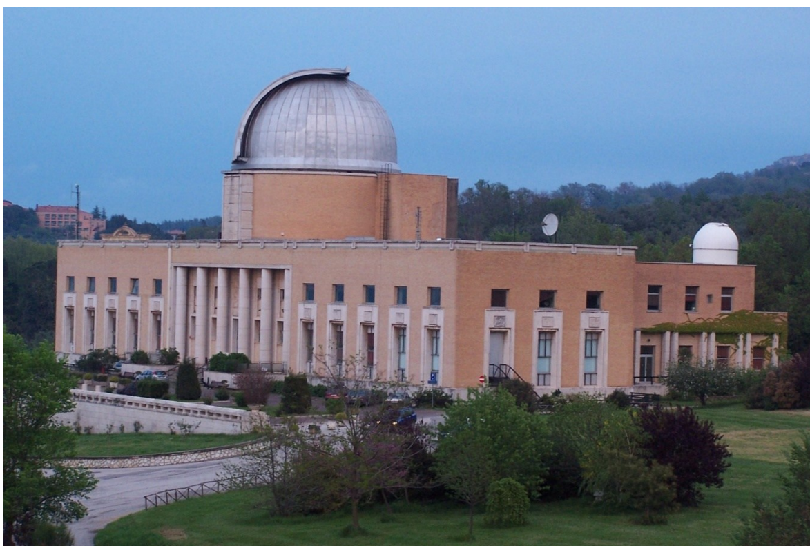
Figura 2 – Vista fronto-laterale Edificio Principale
