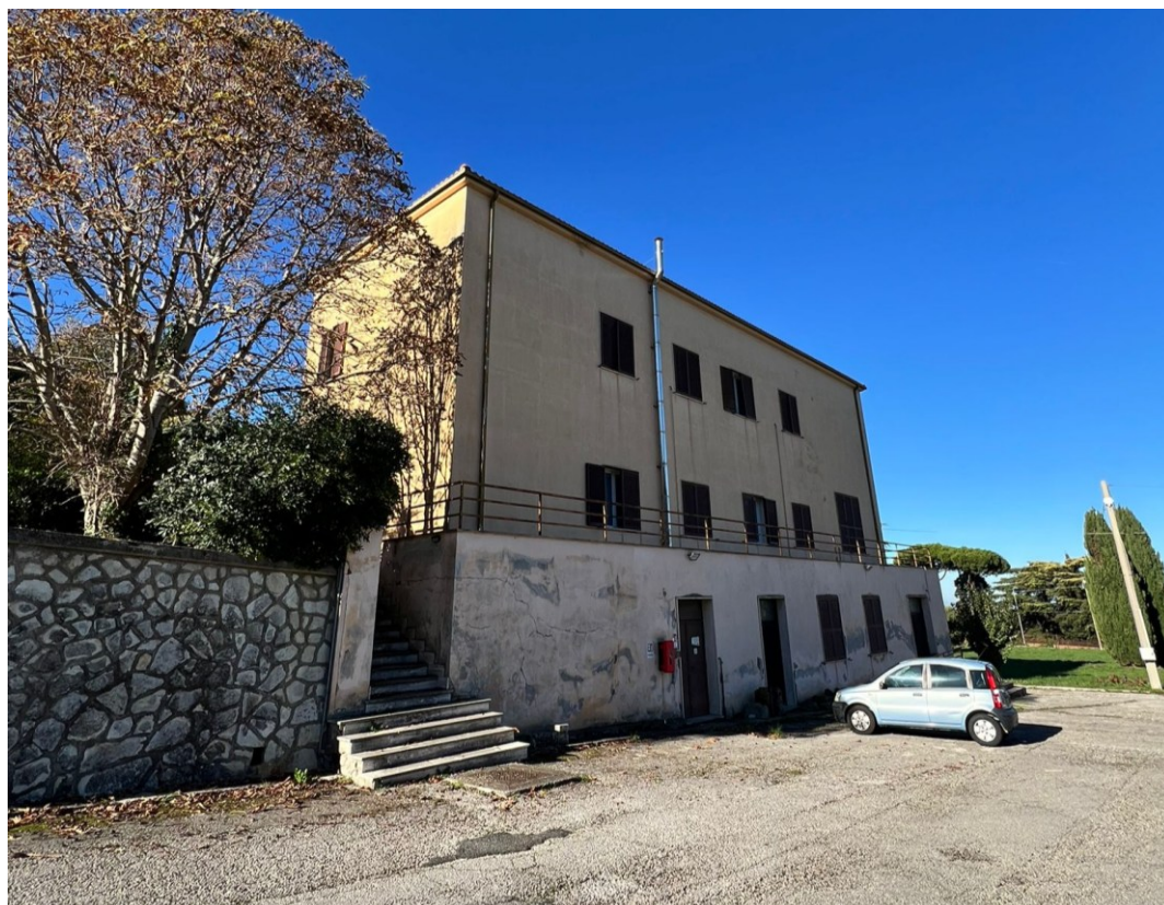
Figura 16 - Vista frontale Foresteria
