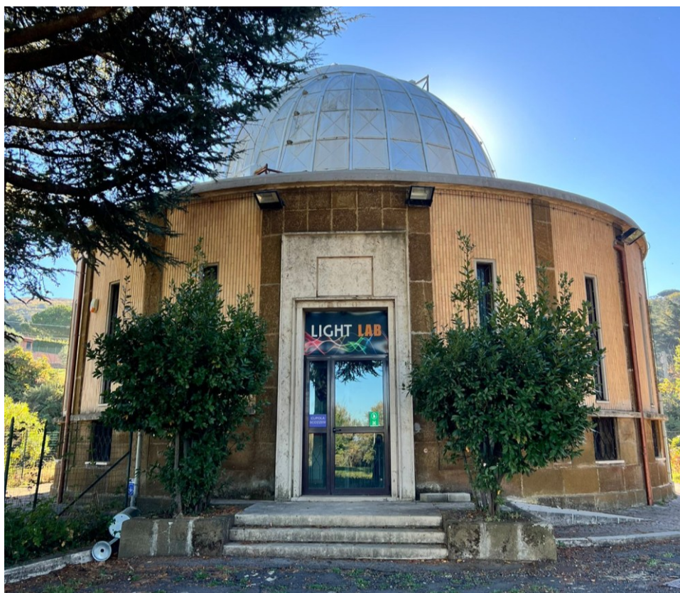
Figura 13 - Vista frontale Cupola degli Scozzesi
