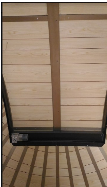
Figura 8 - motore di apertura del portellone della cupola PSPT
