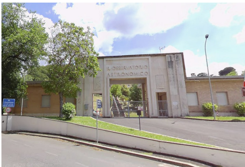
Figura 1 - Ingresso principale dell'OAR
