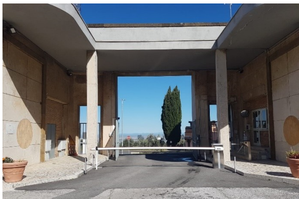
Figura 4 - Ingresso vista dall'interno
