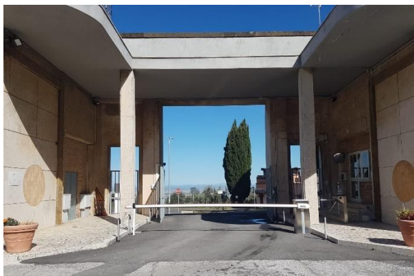
Figura 3 - Ingresso vista dall' interno
