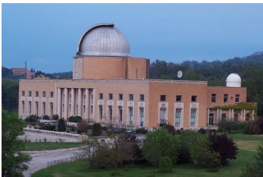
Figura 2 - edificio principale dell'OAR
